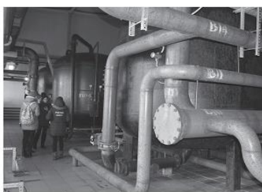
Фильтрация воды через песок и активированный уголь
