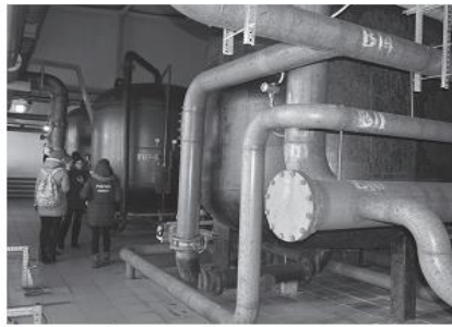
Фильтрация воды через песок и активированный уголь
